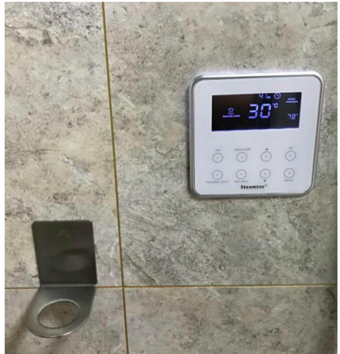
Рисунок 9 Установка контроллера
