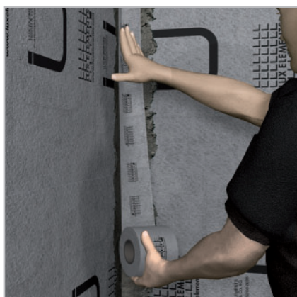
Стыки и углы уплотняются при помощи ленты DRY-DBV
